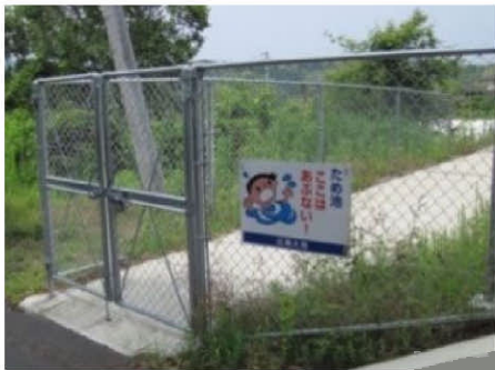
侵入防止フェンスの設置
