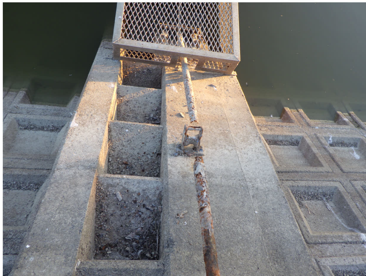
スピンドルの座屈や破断 (過去の点検調査より破断事例)
