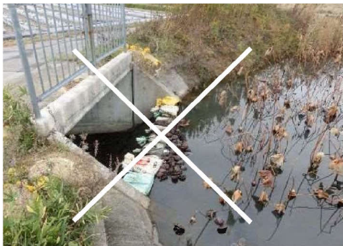
土のうによるかさ上げ
