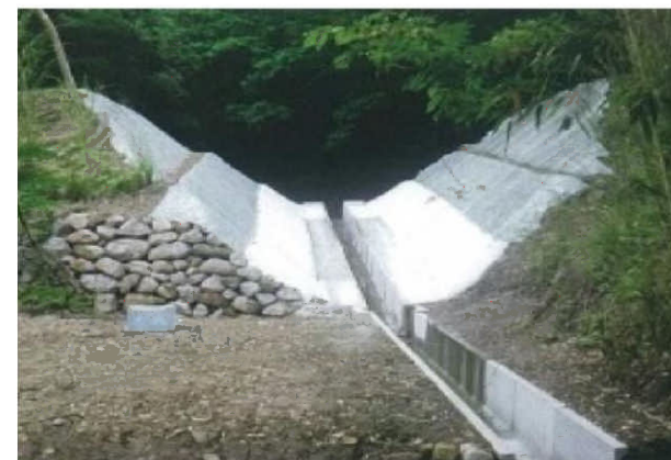
廃止工事（開削）
